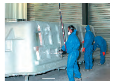
Pose des renforts + résine de protection
