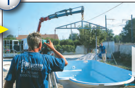
4 MISE À NIVEAU
