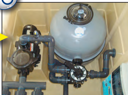
10 RÉALISATION DU LOCAL TECHNIQUE
