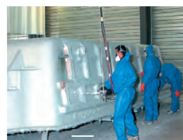
Pose des renforts + résine de protection
